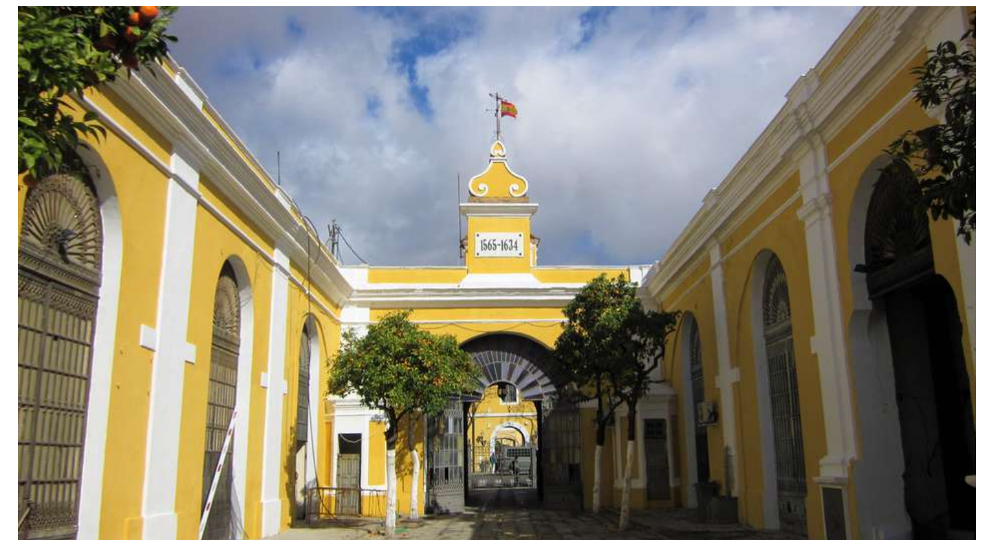
CONSULTORÍA REHABILITACIÓN PASSIVHAUS EN EDIFICIO HISTÓRICO - REAL FÁBRICA DE ARTILLERÍA SEVILLA: C&A
